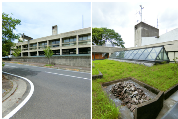
1) 伊賀市庁舎外観・屋上
