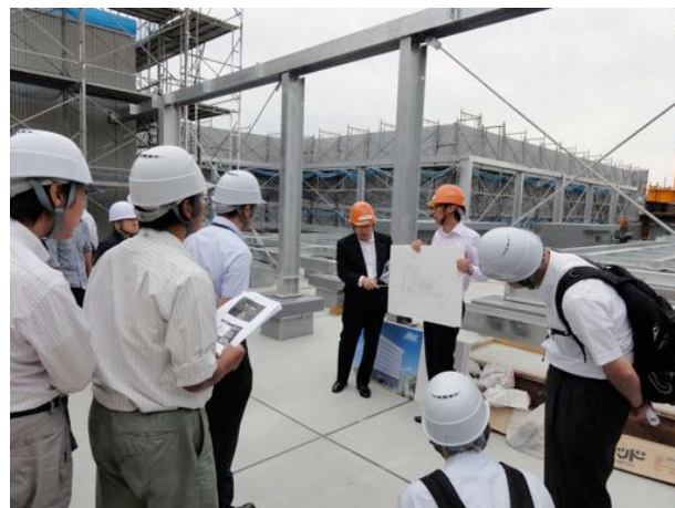
三交不動産本社新社屋ビル建設現場 見学会の様子
