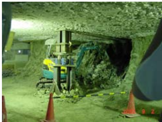
写真-4 地下の掘削の様子 (県庁建物の地下にて)
